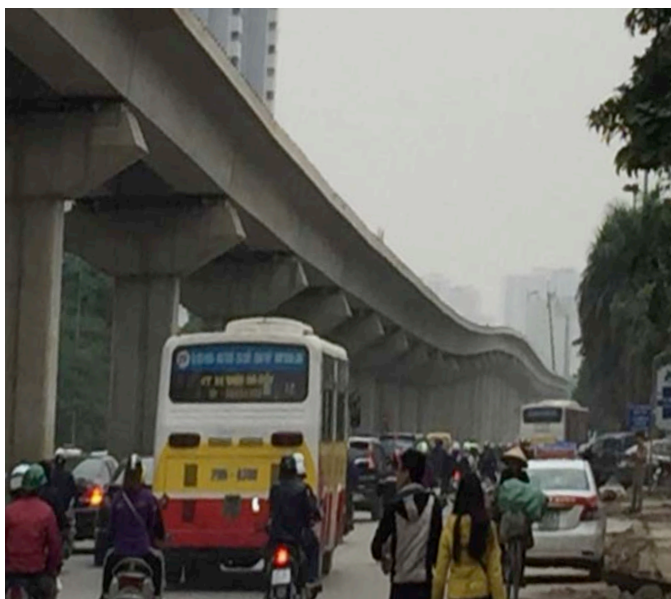
写真12 デコボコの形になっている建築中のモノレール 筆者撮影 2015年12月
