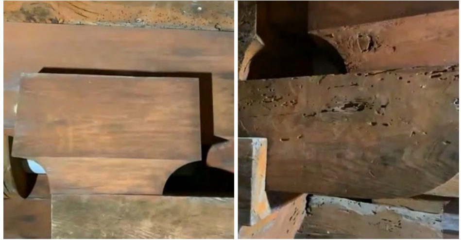
写真5： 鉋で仕上げた平滑な面 (左)と鉋で仕上げた凸凹 な面(右)
