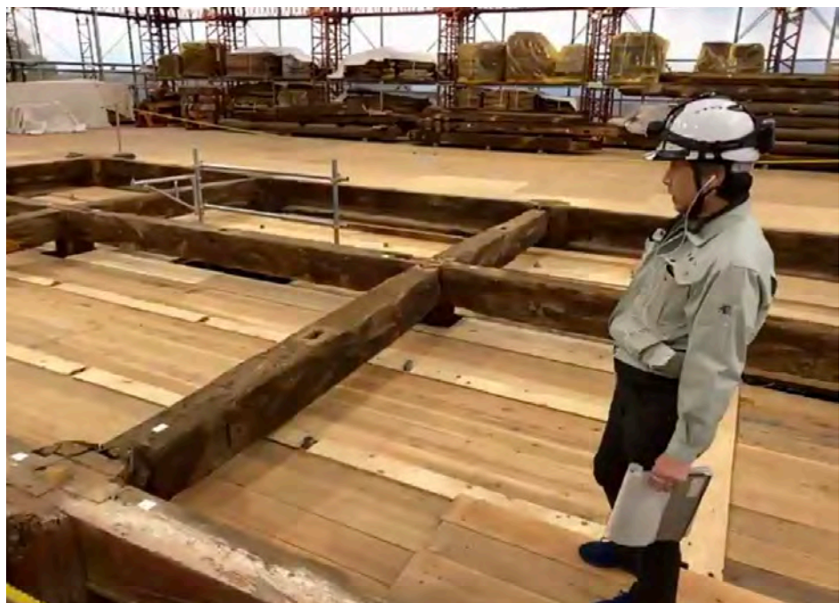
写真9： 端部に穴のある梁
