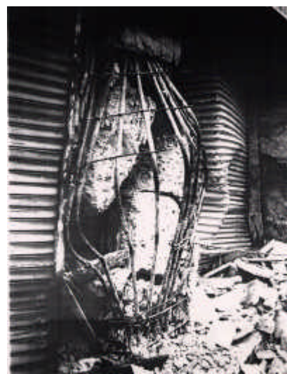
写真-2 阪神地震被災の RC 柱
