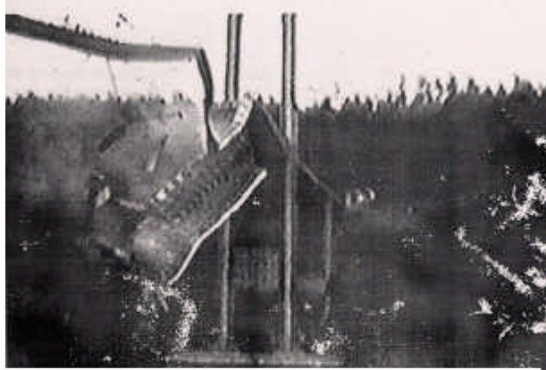
写真-3 タコマ橋崩壊の瞬間
