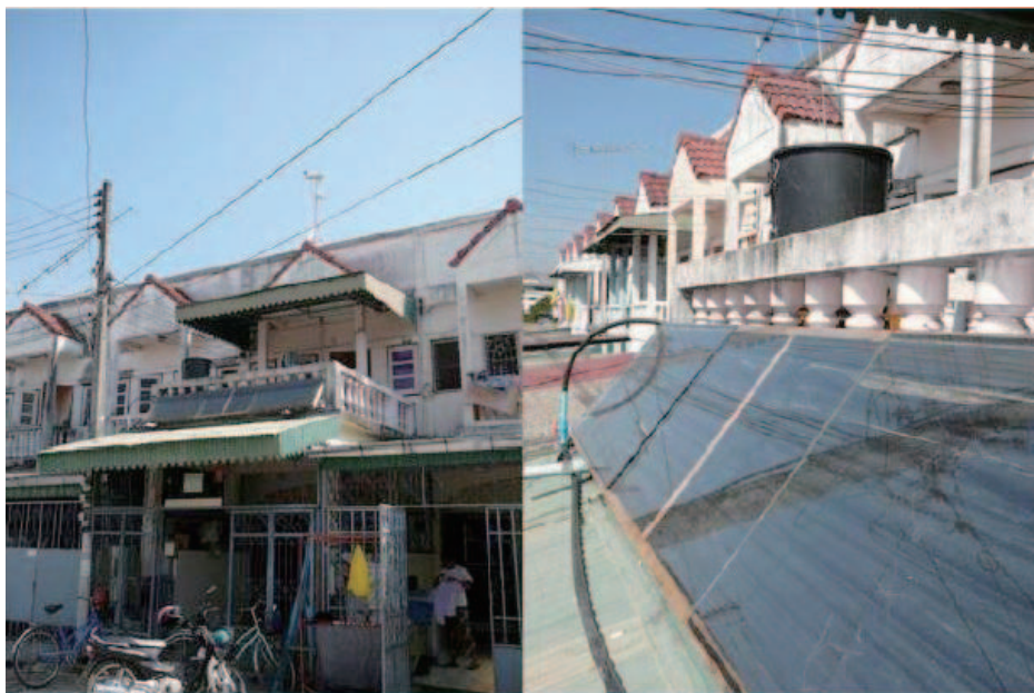
図4 タイの住宅に設置された太陽熱集熱吸収装置
