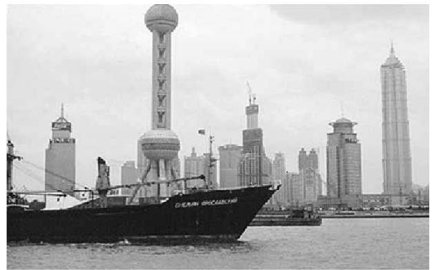
図3 テレビタワーと88階ビル
